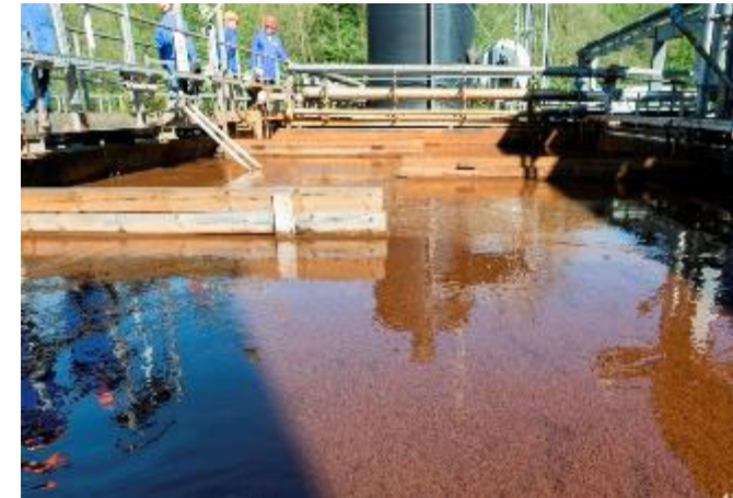
WTP Schlema-Alberoda: lime precipitation
